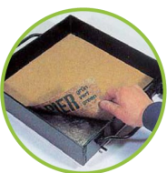
Waschbetonpapier in Schalung einlegen (bedruckte Seite nach unten)
