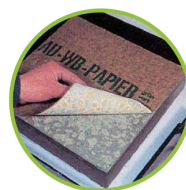
Am nächsten Tag: Beton entschalen, Papier abziehen
