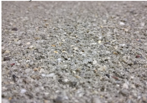
Detailfoto von Betonoberfläche nach Sandstrahlvorgang unter Verwendung von HEBAU®PowerGrit Sandstrahlgranulat.
