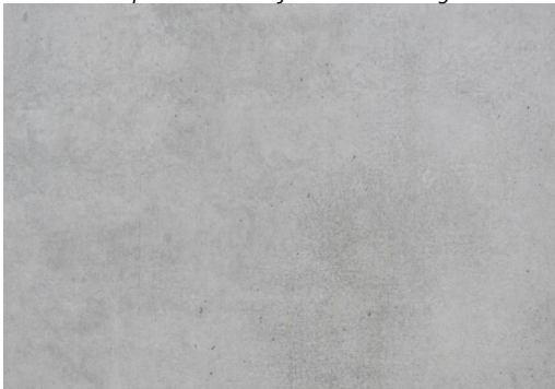
Vorher: Betonplatte ohne Oberflächenbearbeitung
