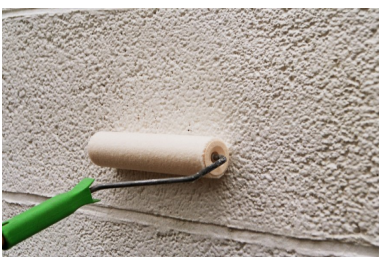
Graffitienschutz PROWALL II auf Wandfläche applizieren, z.B. mit Roller.
