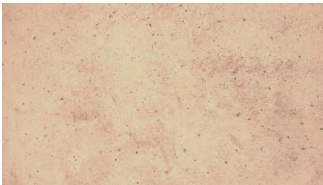
Glattgeschalter Sichtbeton der Rezeptur zum Vergleich. Standard fairfaced concrete of mix design to compare.
